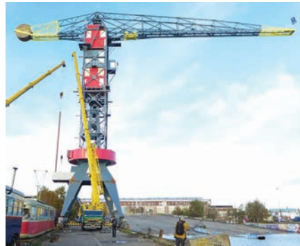
> Kraanhotel, foto De Gebouwendigs
