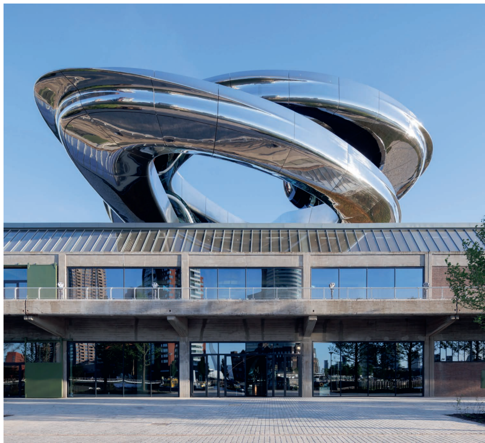
> Fenix met Tornado, foto Iwan Baan
